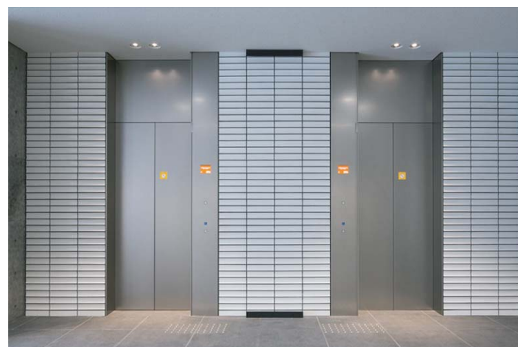
エレベーターまわり
