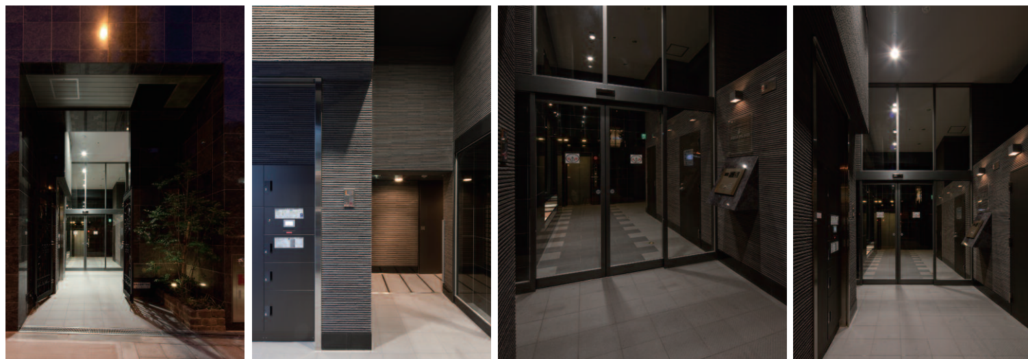
エントランス入口全景
