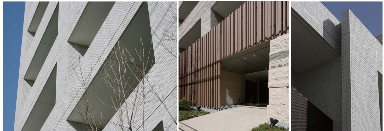
南東側/近景見上げ
