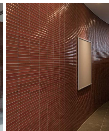
エントランスホール内観近景
