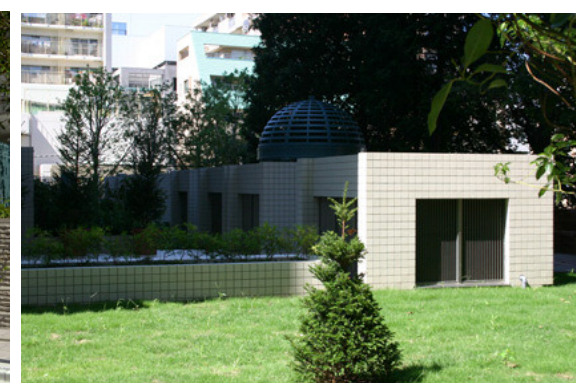
中庭駐輪場外壁
