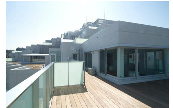
テラスより外観を見る
