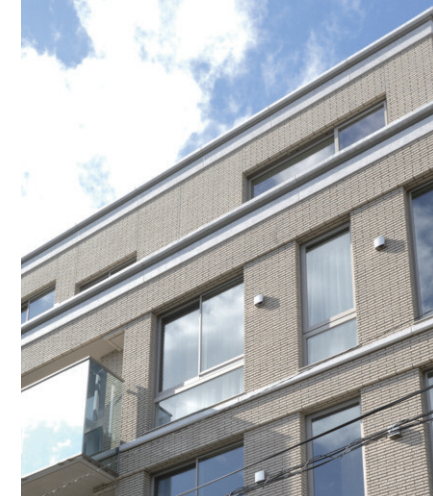
北東側見上げ
