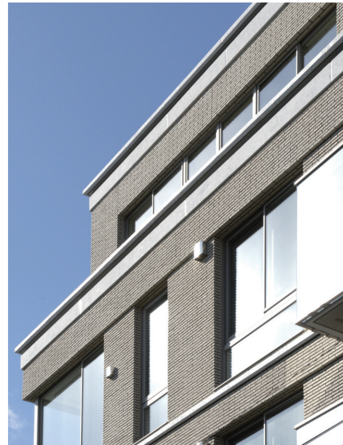
北東側見上げ
