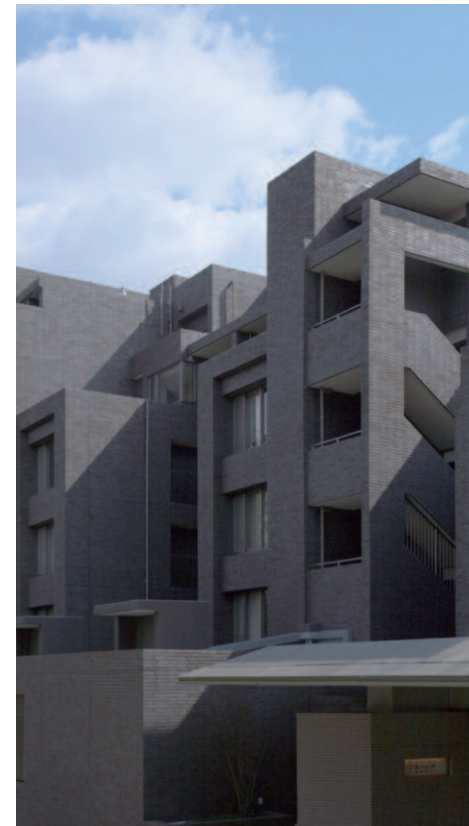
北西側エントランス全景
