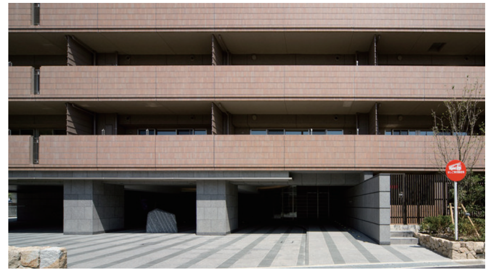
西側エントランス
