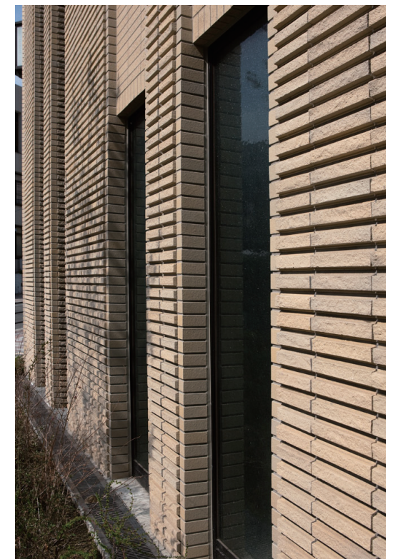
南側壁面開口部
