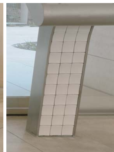
オートロック操作盤脚部
