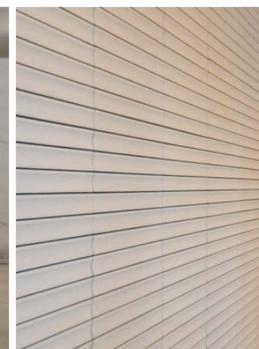
サブエントランス前通路壁面
