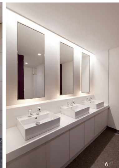
1~5階の洗面器はジェットボウルを採用。サイドバックガードの立ち上がりによってカウンターへの水はねを防ぎ、荷物を水濡れせずに置くことができる。6階はベッセルタイプを採用し、すっきりとしたデザインで意匠性を高めている。
