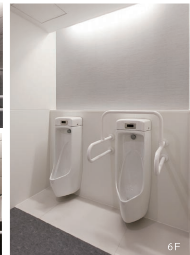
フロアごとに壁・床のタイルやブース色等に変化をつけ、異なるデザインに仕上げている。大便器には立ち座り用に、小便器には身体を支える用に手すりを設置。
