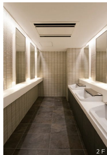
1~5階の洗面器はジェットボウルを採用。サイドバックガードの立ち上がりによってカウンターへの水はねを防ぎ、荷物を水濡れせずに置くことができる。6階はベッセルタイプを採用し、すっきりとしたデザインで意匠性を高めている。
