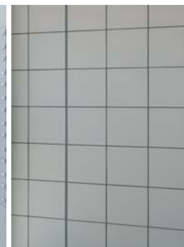
バルコニー外装壁タイル
