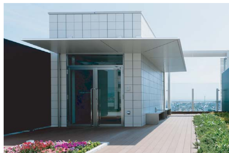
屋上庭園出入口
