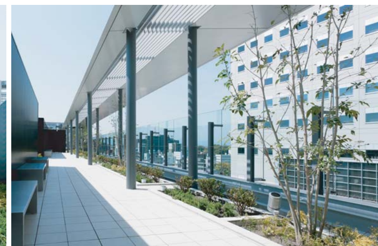
屋上庭園外装床
