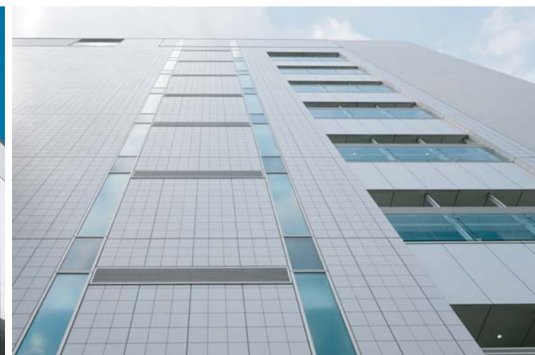
外装壁見上げ
