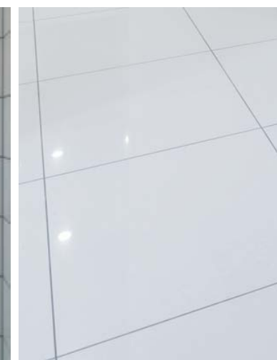
トイレ内装床タイル
