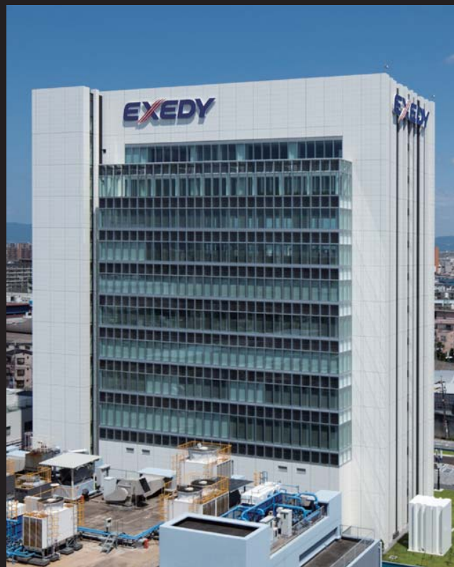
南側/外観全景
