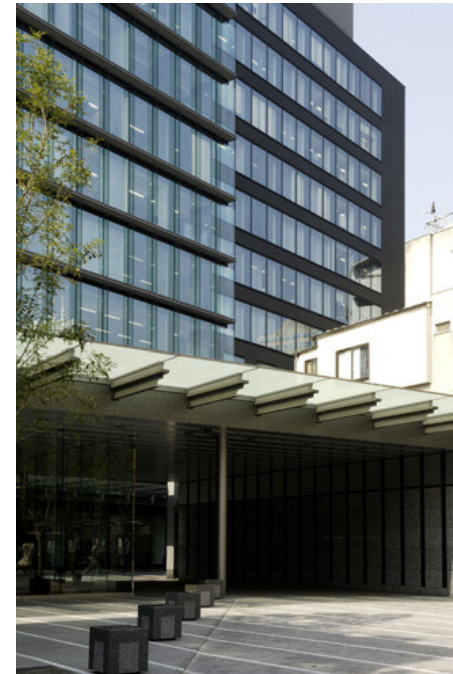
南東側ファサード
