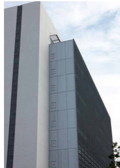
北東側見上げ
