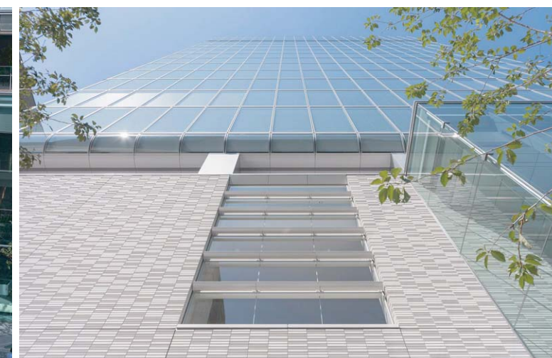
外装壁見上げ
