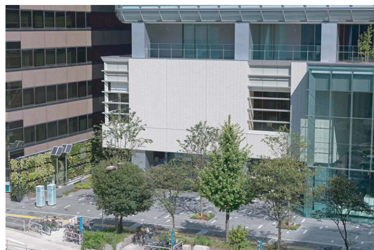
外装壁タイル全景
