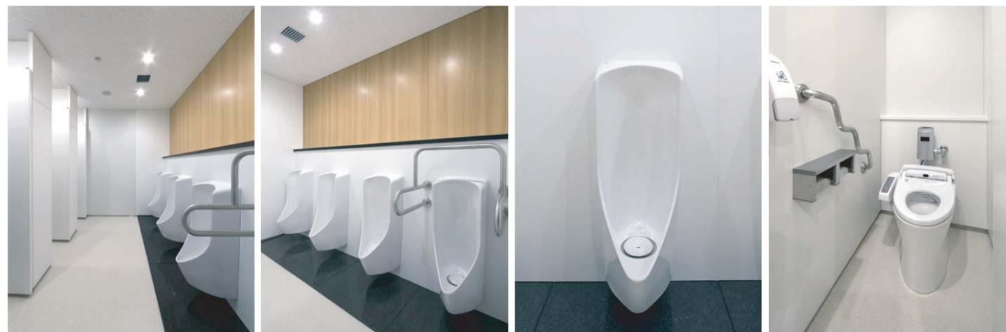
男性用トイレには、洗浄水を使用しない、環境に配慮した無水小便器を設置。低リップ設計で誰にでも使いやすく、凹凸のないシンプルな形状は清掃性・デザイン性にも優れている。大便器は6L洗浄の超節水ECO6タイプ。センサー一体形フラッシュバルブと組合せ、より一層エコで衛生的なトイレ環境に。
