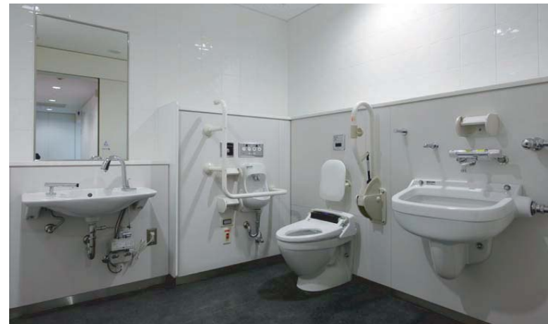
多目的トイレには、オストメイト用汚物流し、ユニバーサルシートを設置。
