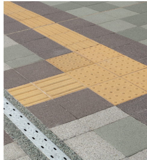
視覚障害者用タイル交差部
