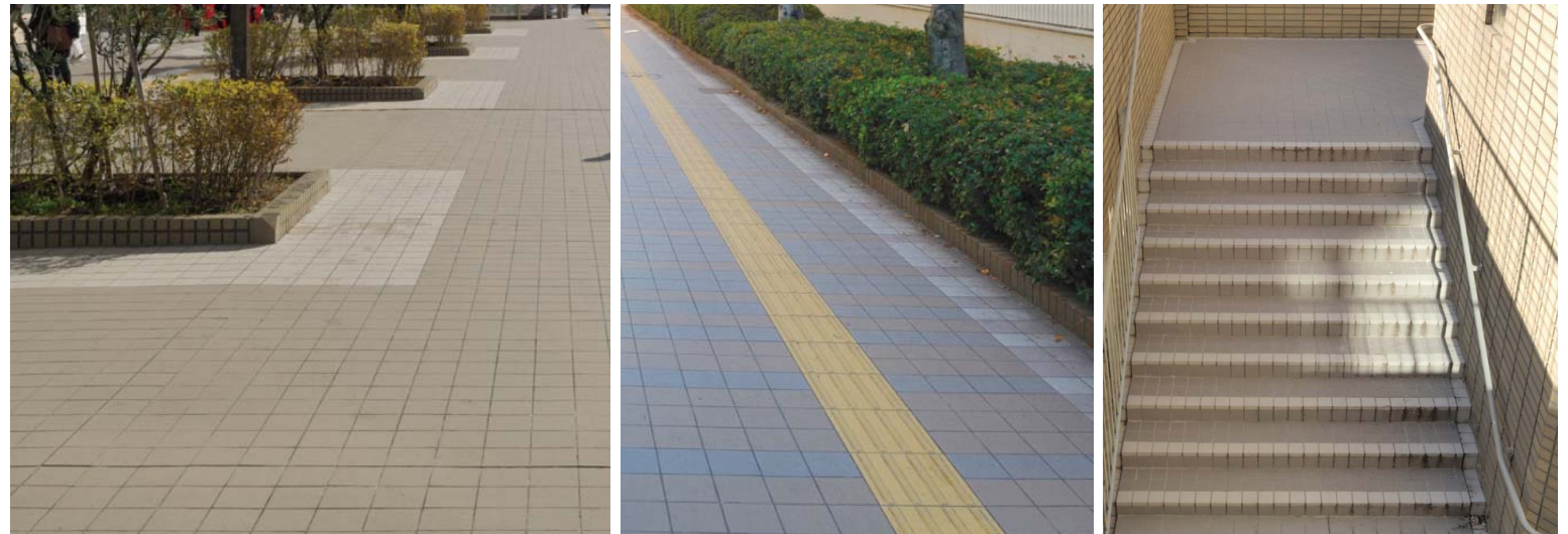
植栽柵と歩道空間
