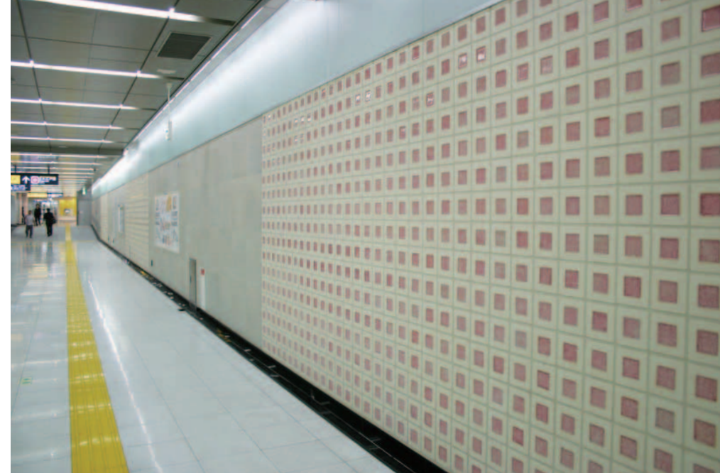
コンコース階全景（右側）
