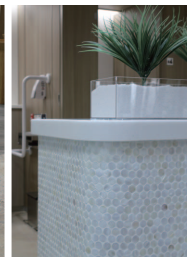
女子トイレ手洗いカウンター:壁
