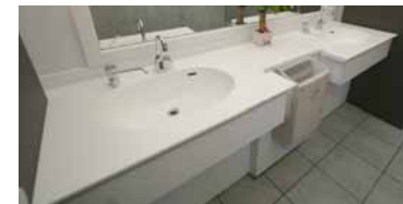
洗面カウンター
