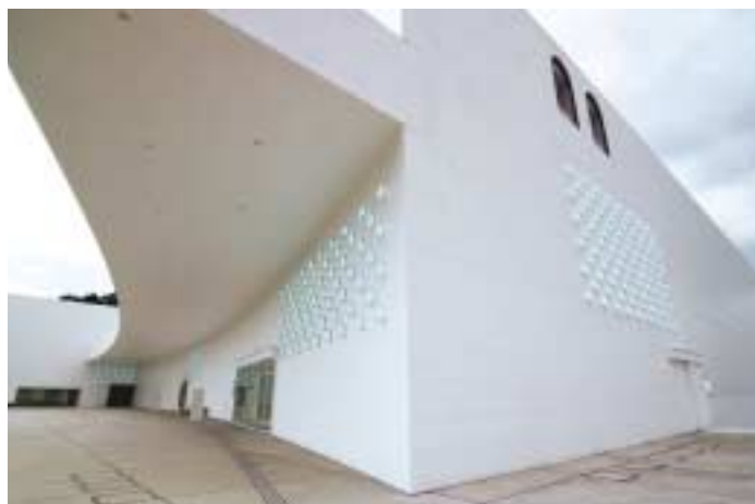
上—三内丸山縄文遺跡に通じる北側出入口「ハンチク」とネオンサイン 下—1階エントランス
