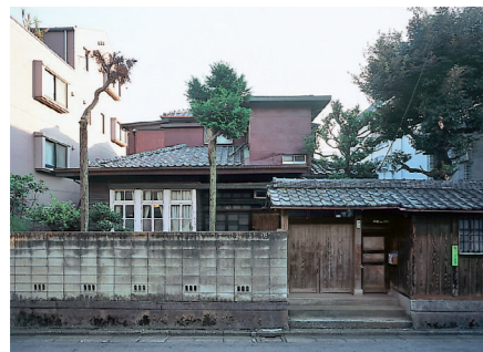
上—正面外観、下—竣工当時 外観を特徴づけるのは採光用の窓を持つ階段室の意匠で、漆喰の白と木部との対比が美しかったが、現在は板で覆われてしまった
