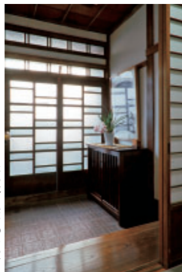
右—玄関内部 構成主義のデザインによるガラス戸と欄間、そこからもれる光が、和洋折衷住宅にモダンな雰囲気を与えている 次ページ—玄関 軒先周りに水平材をまわし、櫓を隠すことでキュービク的な形態表現を意図している。下見板の外壁、白ベキ塗り窓枠、竹を使った戸袋、そして構成的な意匠を見せる引戸、軒の水平材には銅版が張られている
