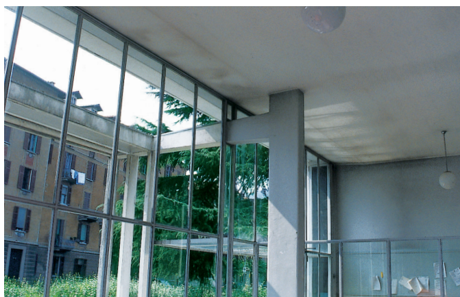
左—ガラス面を貫通するオーニング支持材 上—東側ガラス面 柱手前の壁面にあけられた水平連続窓
