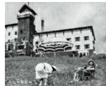
赤倉観光ホテル | 1930年代の国際観光政策による「上信越国際スキー場」のひとつ。玄関を来客用とゲレンデ用に分け、スキー道具のロッカー、乾燥室、手入れ場、靴置き場を備え、かつ温泉にも入浴できる「スキーホテル」の典型となった。大倉喜七郎はここをこよなく愛したという[写真:赤倉観光ホテルパンフレットより]
