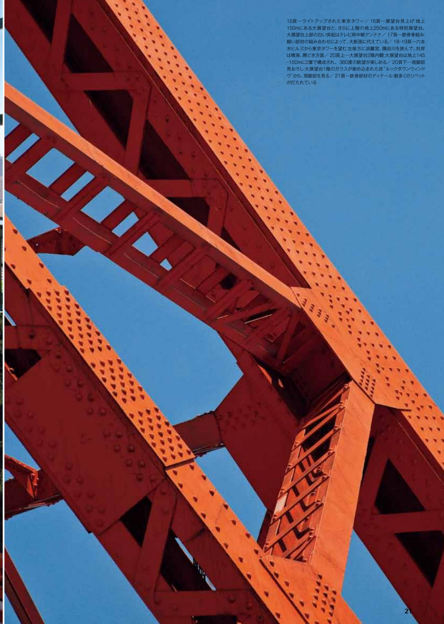
15頁—ライトアップされた東京タワー／16頁—展望台見上げ：地上150mにある大展望台と、さらに上階の地上250mにある特別展望台。大展望台上部の白い突起はテレビ局中継アンテナ／17頁—鉄骨組み：細い部材の組み合わせによって、大断面に代えている／18-19頁—六本木ヒルズから東京タワーを望む：左後方に浜離宮、隅田川を挟んで、対岸は晴海、勝どき方面／20頁上—大展望台2階内観：大展望台は地上145-150mに2層で構成され、360度の眺望が楽しめる／20頁下—塔脚部見おろし：大展望台1階のガラスが嵌め込まれた床「ルックダウンウインドウ」から、塔脚部を見る／21頁—鉄骨部材のディテール：数多くのリベットが打たれている
