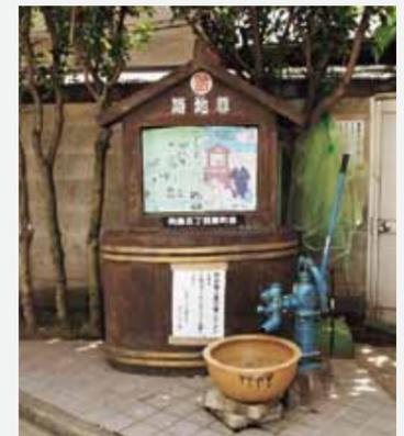
1988年に設置された路地尊2号基(墨田区向島5丁目)：隣家の屋根に降った雨水を3tの地下タンクにため、手押しポンプでくみ出す仕組み。近所でボヤが発生した時に、近隣住民がバケツリレーで消火したという実績がある。総工費約200万円。現在区内には21基の路地尊がある【写真:編集室】
