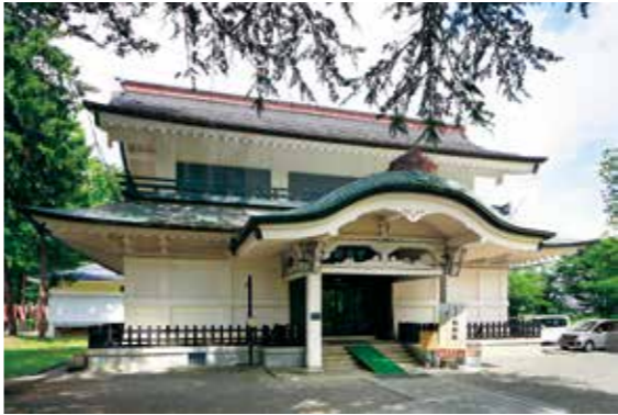
稽照殿は宝物殿で、当時最新の鉄筋コンクリート造を採用。桁行54尺、梁間30尺、上層の窓は展示室内に外光を採り入れるためにある。この窓や欄間、出入口には竣工時から防火設備として自動巻き上げシャッターが設置されていたという
