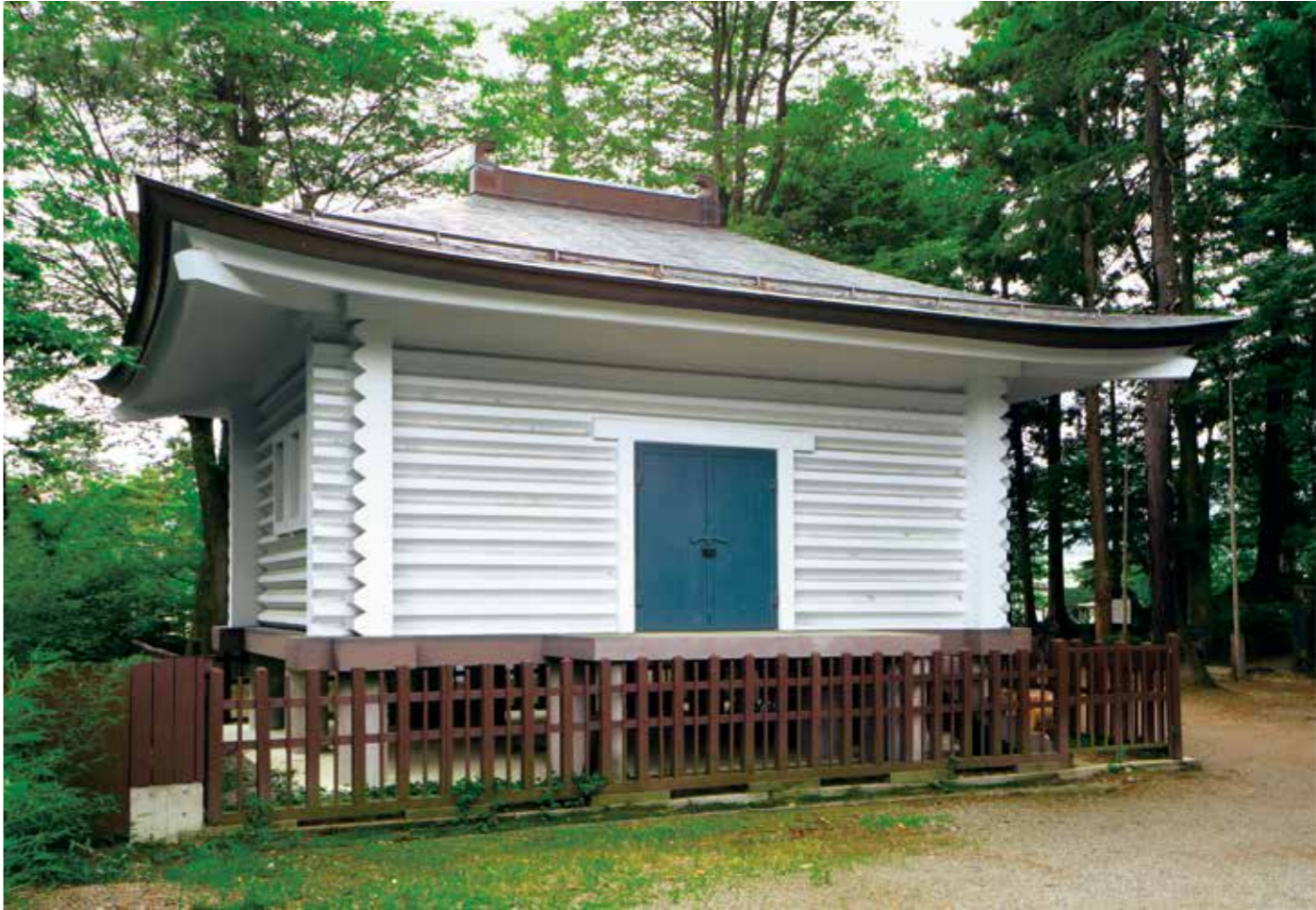
祭器庫も鉄筋コンクリート造ながら、高床式・校倉造りという日本の伝統的な木造建築のスタイルを模している。祭器庫と稽照殿は、本殿に対して左右対称に配置されている
