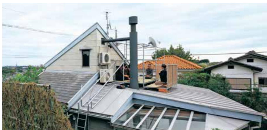
納屋から見たブライエ。正面の建物の右側が1985年の増築部分。屋根に炉を切った空間がある
