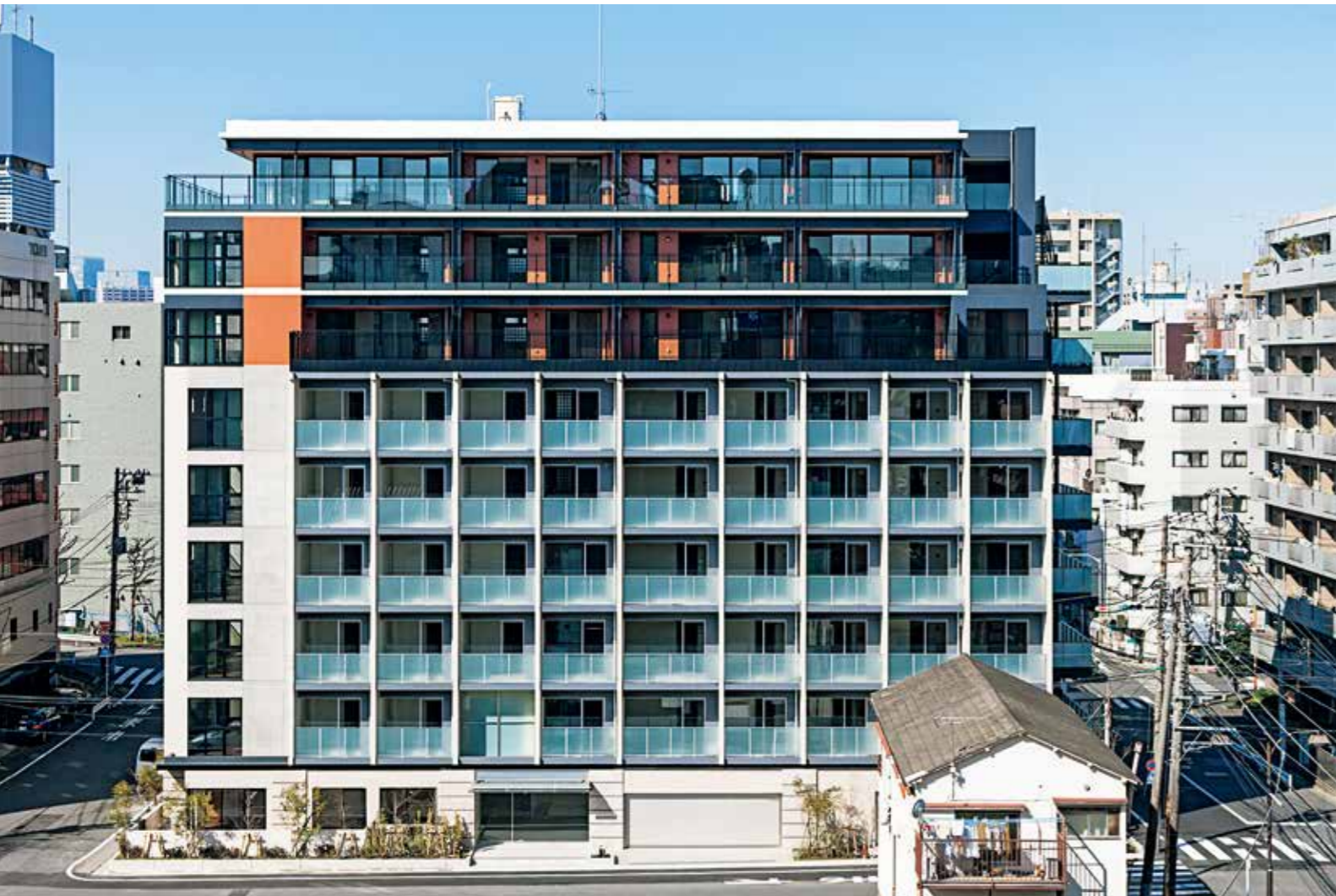
The TriBeCa外観。RC造と鉄骨造の切替え部を境に意匠的にも変化している。鉄骨造の7-9階部には太い柱がないため、良好な眺望を得られる [写真: BAUHAUS NEO]
