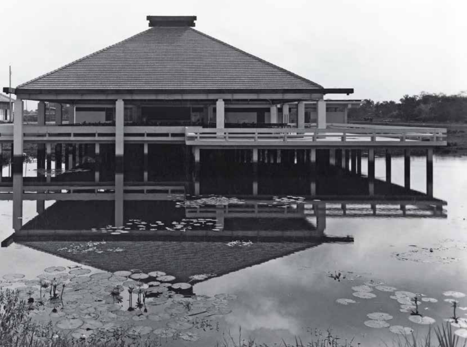
ラカバン農業大学カフェトリウム。雨季の洪水によって建物の床下が水面になっている【提供：坂倉建築研究所】
