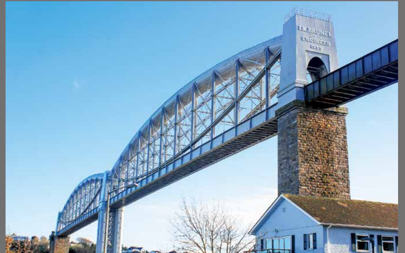
上弦の筒は铸铁、下弦のチェーンは錬鉄でつくられている。ブルネルの死後、彼の名前は橋の入り口に刻まれた【写真：Mark Cole/gettyimages】
