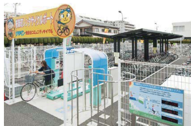
普通自転車と電動アシスト自転車借りられる。太陽光発電システムのシェルターは電動アシスト自転車専用。アルミ板の屋根材は防火性だけでなく、太陽電池モジュールの配線を隠す役目も果たしている
