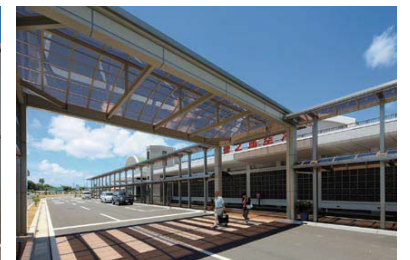
横断歩道にも屋根をつけ、乗車するまでの道のりをくまなくカバー
