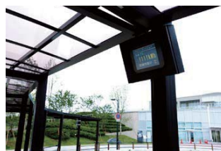
TOEXオリジナル設計の電力ディスプレイ。現在の発電量と累計の発電量を、リアルタイムに表示する。ほか、駅前広場における注意事項や摂津市の標識など、計10パターンを10秒ずつ繰り返し表示
