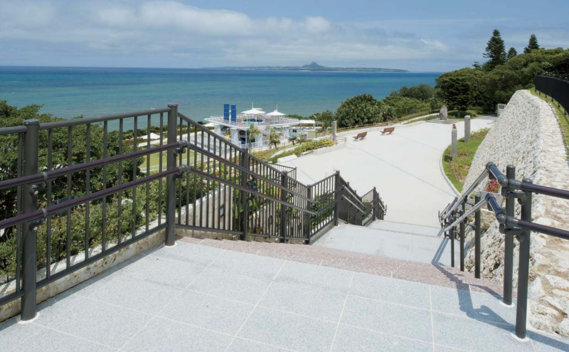
柵と手すりは景観に溶け込むオータムブラウン色
