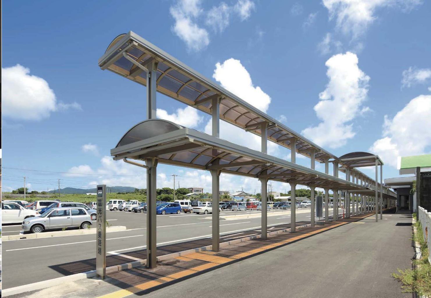
バス停には2段式のシェルターを設置。高い屋根の下にバスが乗り入れられるようになっている
