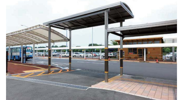
車両が通る部分は高い屋根を組み合わせて対応
