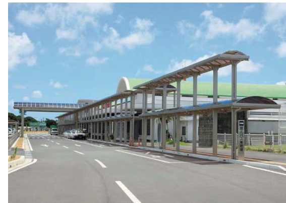
空港には全長107mのシェルターが連なる
