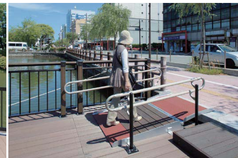
浮桟橋へ導くやさしい手すり
