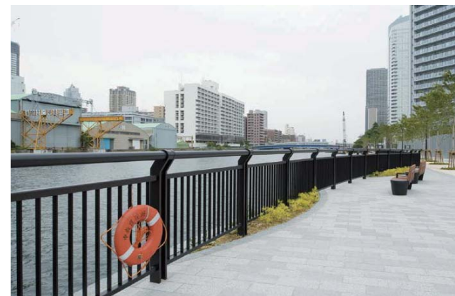
柵は支柱に鍔物を用い、高い強度に仕上げている
