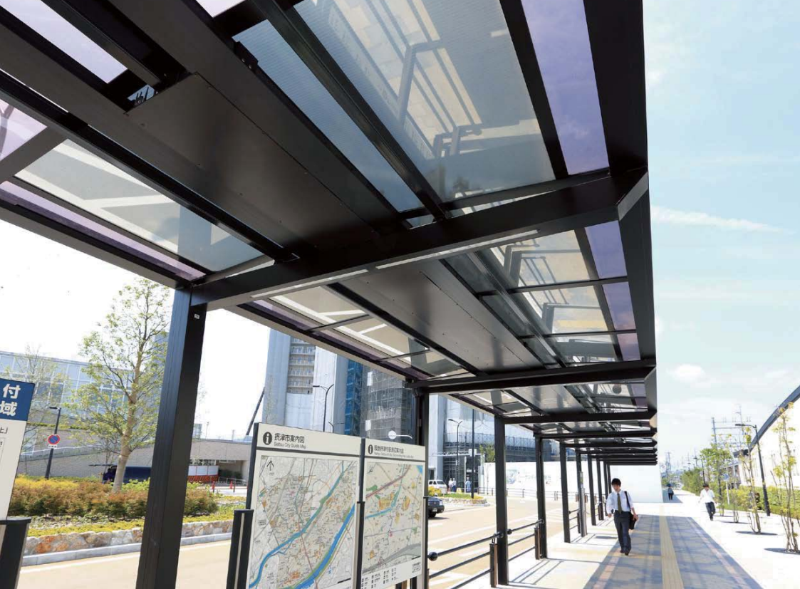
配線は屋根中央部の梁にまとめて、目に触れないようカバーで覆った。内側は屋根材一体型の太陽電池モジュール、外側はポリカーボネートを組み合わせ、光が透過するようになっている
