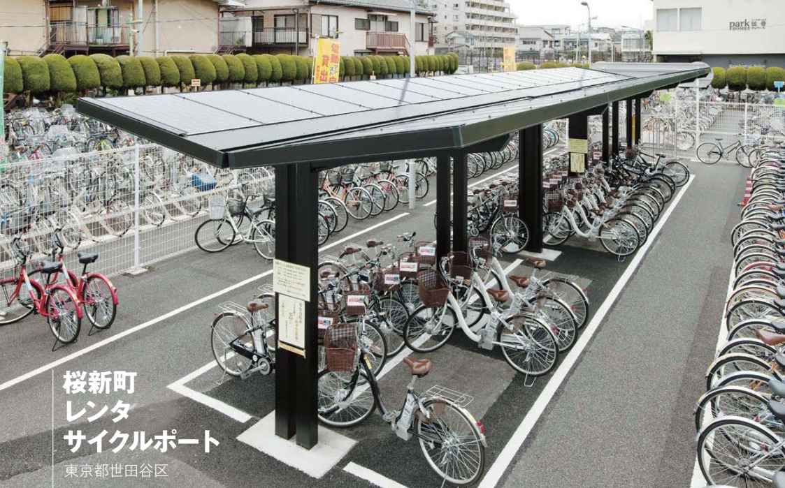
試作を重ね、太陽電池モジュールはフラットヤードの屋根枠内にはみ出さずに収納できるよう設計。屋根の勾配は、通常5度のところを10度にして発電効率をアップさせた
