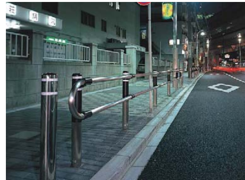
車のライトで光る反射シールが夜間の歩行空間を安全に保ちます (板橋ショッピングロード)
