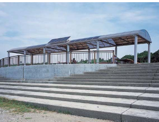
屋根にソーラーパネルを設置して、人工木柵にはLED照明を内蔵
