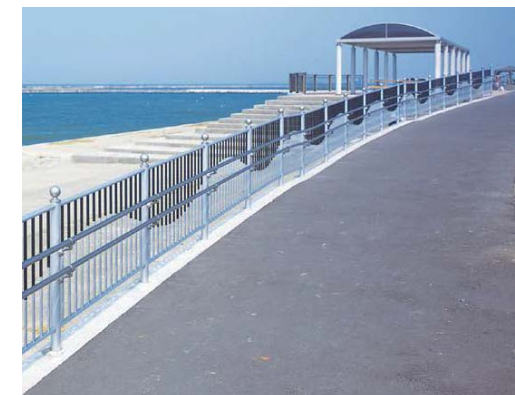
スロープにはバラスターカバーで波形をデザインしたアルミ柵を設置
