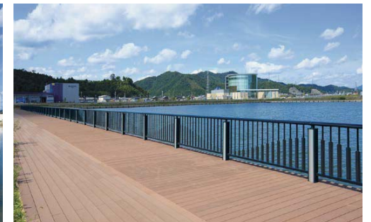
ガラスカーバーで波を表現したアルミ柵。支柱とのツートンカラーが景観を引き立てます
