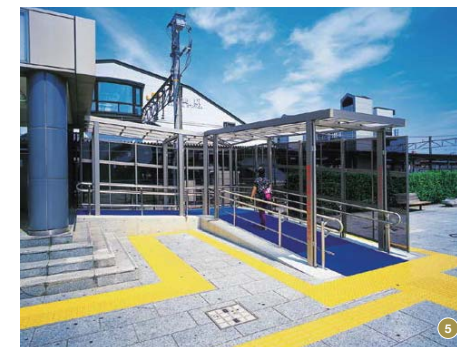
5 駅のバリアフリー化工事で設置されたシェルターと手すり
