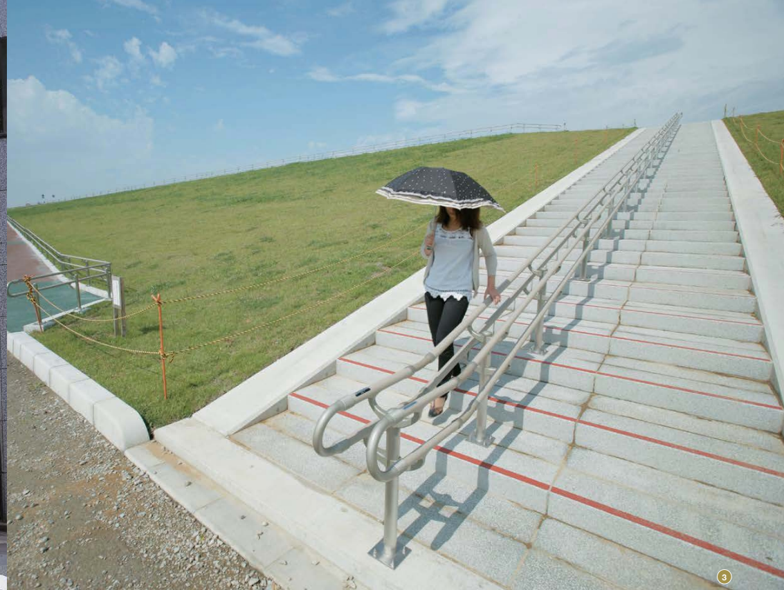
3 幅員の広い階段では、両側から使えるセンター柱タイプを推奨します
