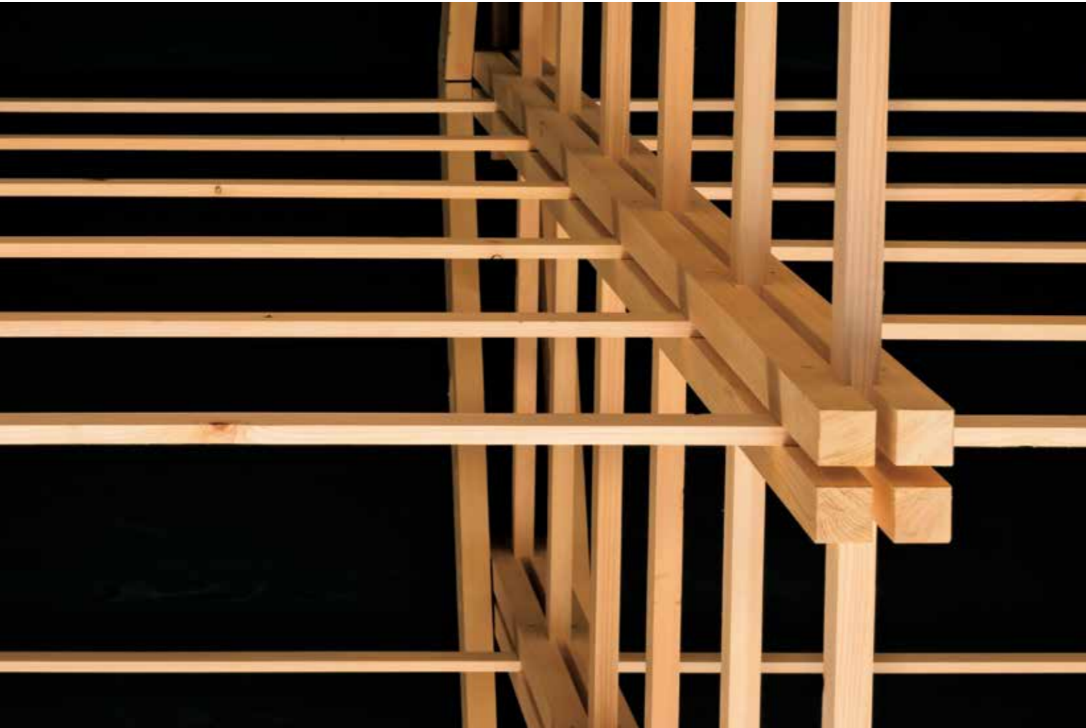
工学院大学弓道場の屋根架構を下から見る。4本1組とした36mm角の束が、水平方向の貫を十字形に挟み込んでいる【写真：小川重雄】
