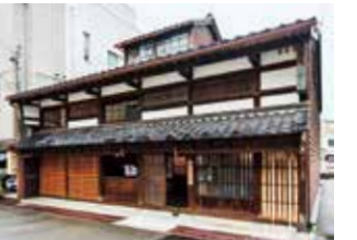
旧川緑米穀店 [現・金澤町家情報館] (江戸末期竣工、2016年改修)
