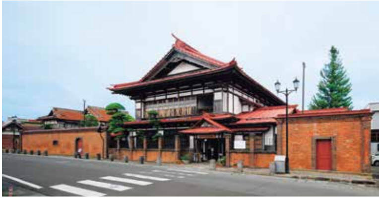
06 | 旧津島家住宅（太宰治記念館「斜陽館」）
