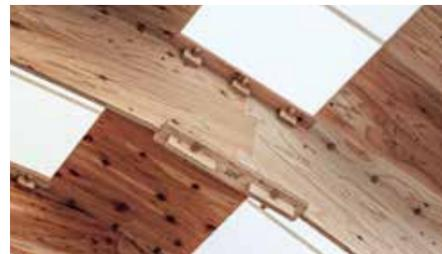
アーチフレームのくさびジョイント [写真：KMDW]
