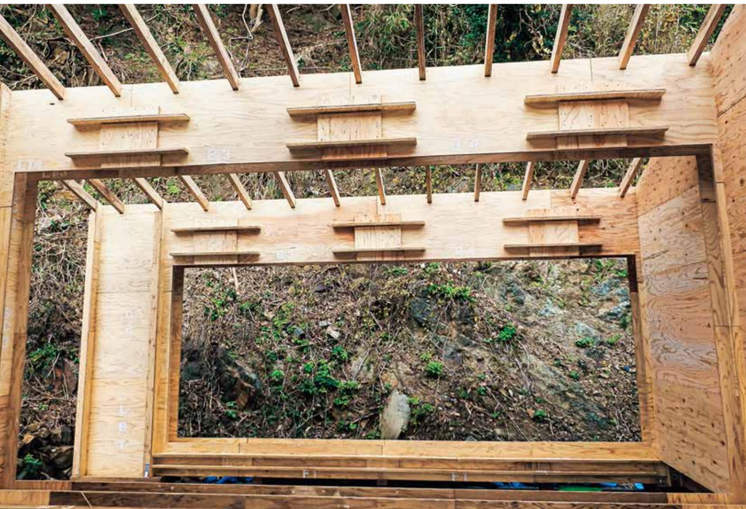
建方中の前網浜ベニアハウスの口の字形フレーム [写真: 鈴木啓/ASA]
