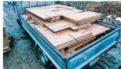
南三陸「魚竜の湯」プロジェクトでは、2tトラックでプレカットした部材を運搬 [写真：鈴木啓/ASA]
