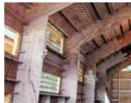
家形のフレームのジョイント部分。凹凸部に木プレートをはめ込み固定する [写真：慶應義塾大学SFC小林博人研究会]
