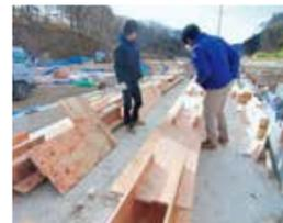
搬入した部材で組み立てた梁 [写真：鈴木啓/ASA]
