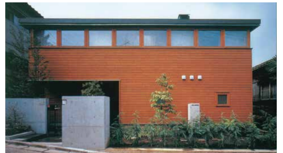
北側外観。初期の代表作「あかりのや」に共通する水平連続窓が用いられた [写真：村井修 / 出典：日経アーキテクチャ 2000年9月18日号]
