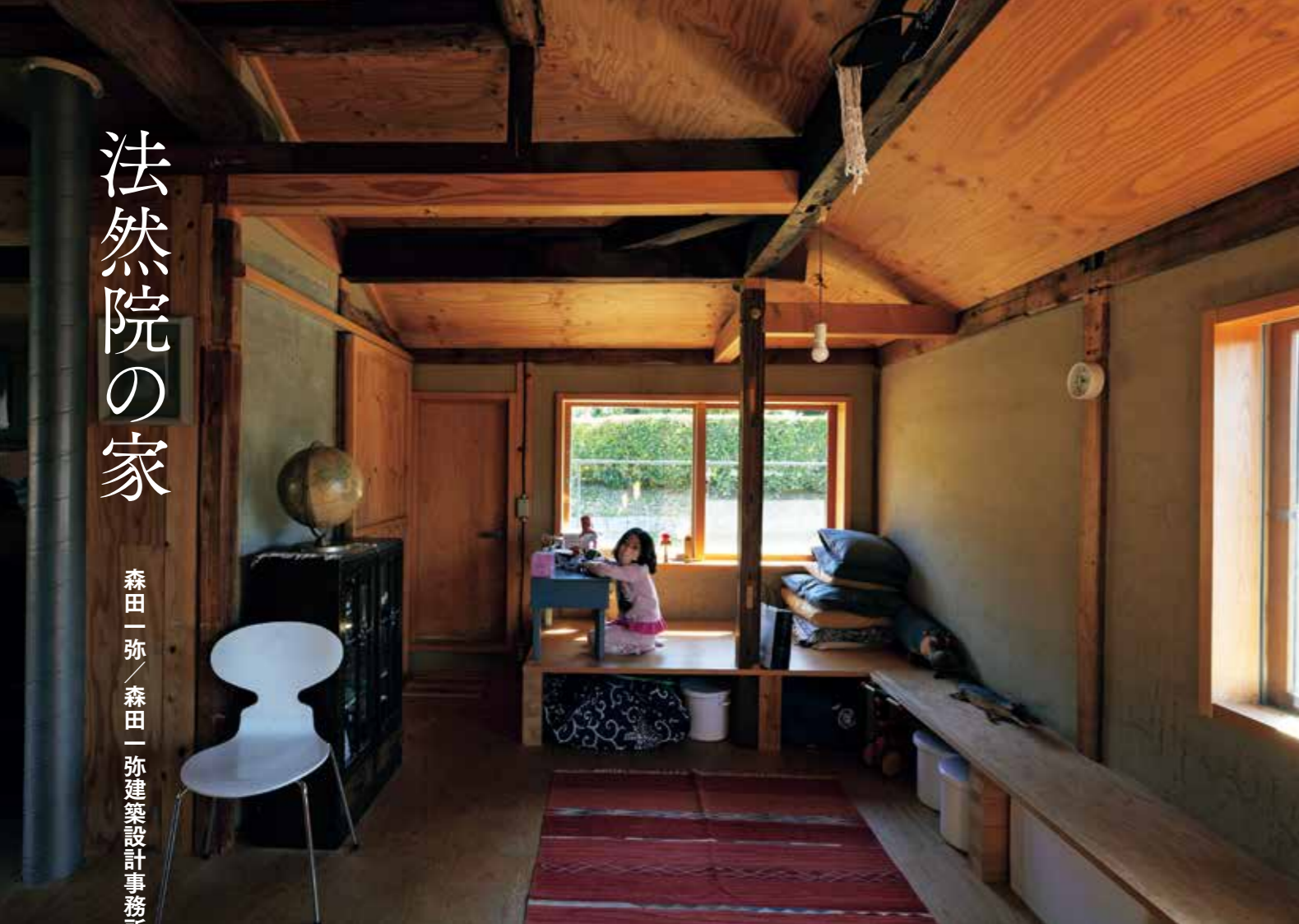
2階に現れた架構。新旧部材の組合せがわかるようにしている
