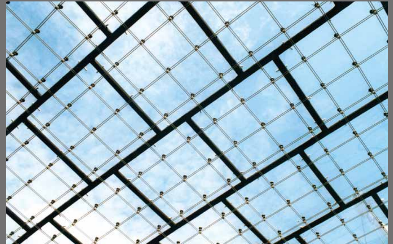
内部から見上げた膜屋根。格子状に張られたケーブルは2本1組になっており、その交点から伸びる束材がアクリルの屋根を支える構成となっている [写真：Graph Studio]
