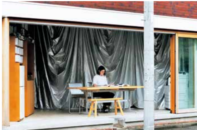
等々力の小さなシェアオフィス (2018) 三叉路の角地に立つRC造マンションの1階テナントを改修した、30㎡ほどの小さなシェアオフィス。3面で接道する既存の大きな開口部を生かし、それぞれに対して「執務」「工作」「打ち合わせ」の3つの行為を割り当てて配置し、空間化した。ある行為に特化した小空間は、その奥行き狭さから、外部とつながるファサードとしてまちに現れる。カーテンはオランダデルンデによる [撮影：miCo]
