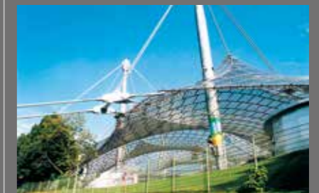
圧縮材の太い柱が引張材のワイヤーを介して膜屋根を支えることで、軽快な印象の屋根とシンプルなディテールを実現している [写真：Graph Studio]
