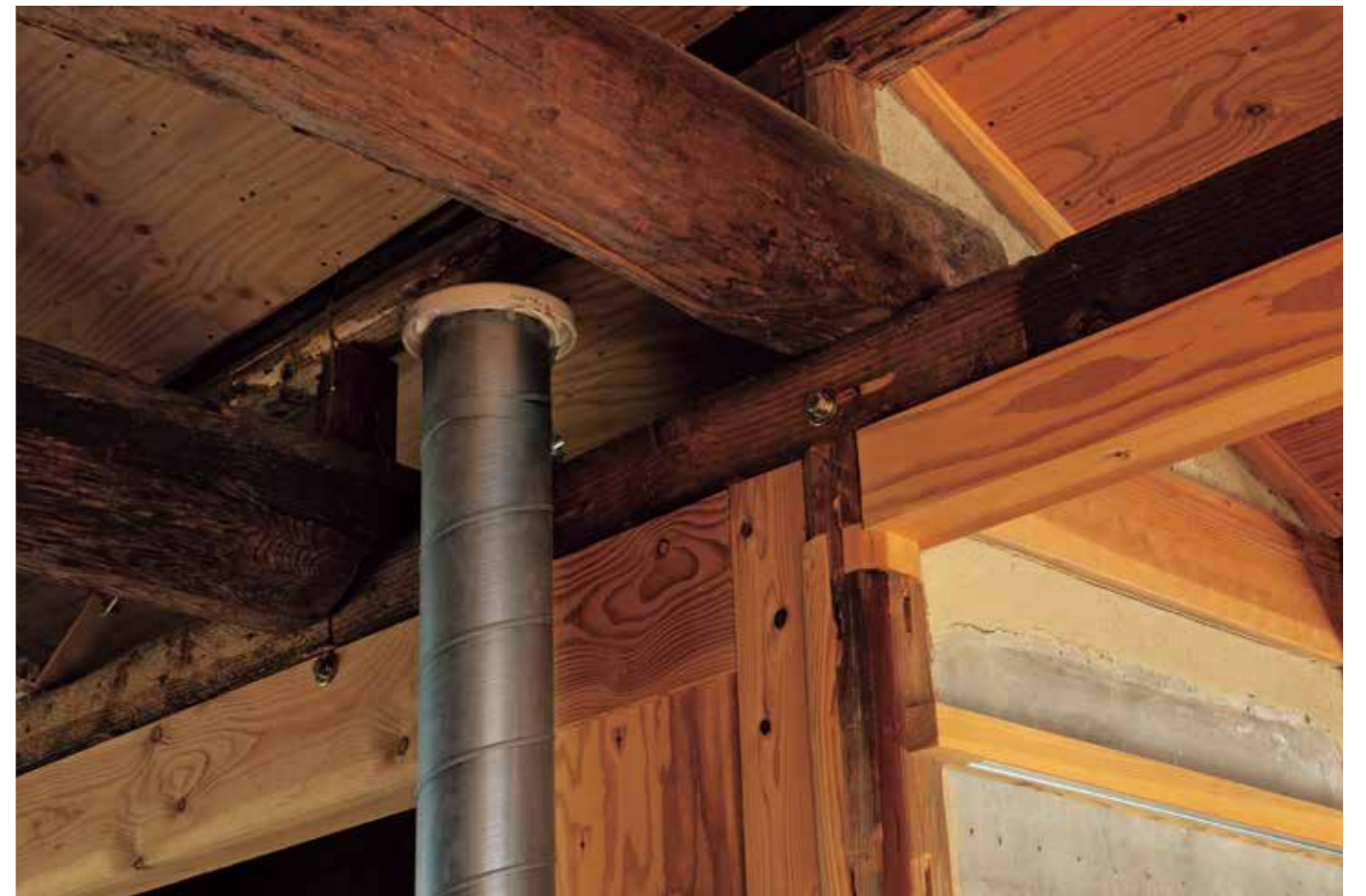
2階に現れた架構。新旧部材の組合せがわかるようにしている
