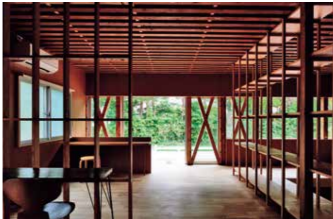
久我山の住宅 (2014) 東京の住宅地に立つ木造住宅の改築。庭先には隣の緑地が広がっており、境界の塀を取り払うことで、室内から庭、緑地へと連続的に広がる住空間が目指された。木造軸組構造の既存建物は健全性が十分に保たれていたため、積極的に既存部分を残し、新しいものと古いものを組み合わせて全体を再構成している [撮影：鳥村綱一]
