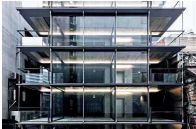
La・La・Grande GINZA (2017) 銀座に立つ地上6階地下1階建ての商業テナントビル。道路側に避難用動線(避難階段、エレベーターホール、エントランス、避難バルコニー)をまとめ、厚さ135mmの極薄片持ちスラブとすることで、階高を抑えて貸床面積を最大化しながらも、開放的で奥行きのある「ファサード空間」を実現した。極薄スラブの端部には振動抑制のためタイロッドが設置されている [設計：大成建設一級建築士事務所、撮影：エクス]
