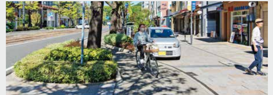
部分的に、歩道と自転車道の間副道（荷捌きスペース）が入り込む道路構成が、花園町通りの特徴のひとつ。3種類の道は、段差を設けずにタイルの色や割付けの差によって区別されており、イベント開催時など状況に応じた空間利用が可能になっている
