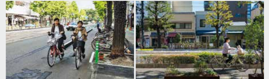
今回の整備にあたって実施された社会実験の様子（左）。自動車道に緑石を仮設して自転車道をつくり、地域住民に実際に利用してもらうことで、適切な道幅などを検証した。写真右は整備後の自転車道 [提供（写真左）：設計領域]
