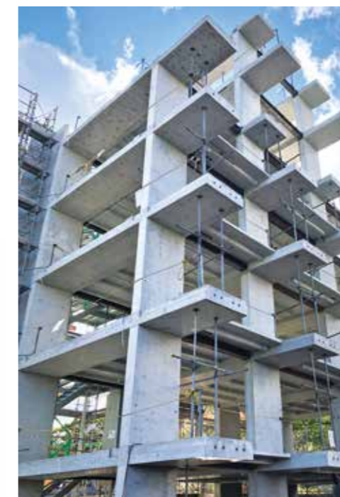
HAKUVillasの建て方。2本のPCa壁柱を立て、その上にPCa梁を載せて圧着接合する施工プロセスのため、支保工が不要となる [写真: AIG]
