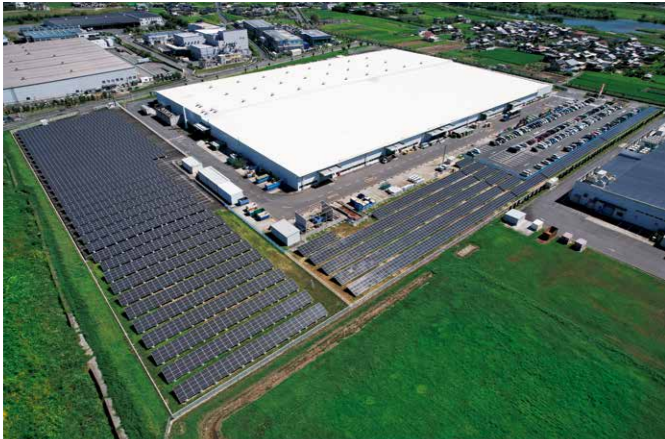
【写真1】自家消費型太陽光発電設備を設置したLIXIL熊山工場
