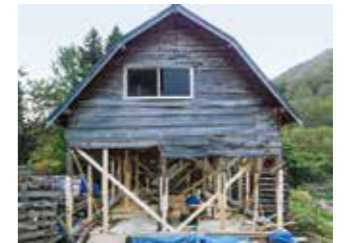
曳屋・基礎打設・柱土台交換(2018) [写真:三木佐藤アーキ]
